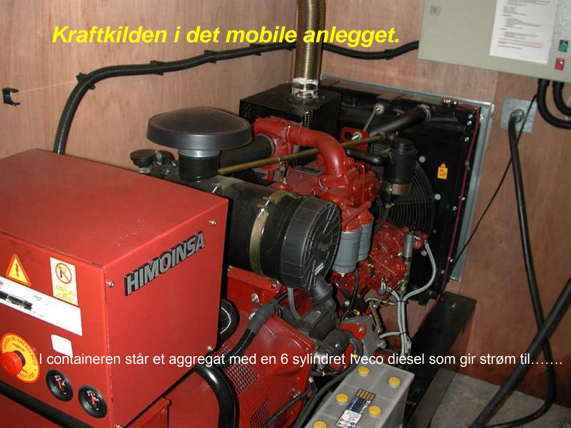
I containeren står et aggregat med en 6 sylindret Iveco diesel som gir strøm til.....
